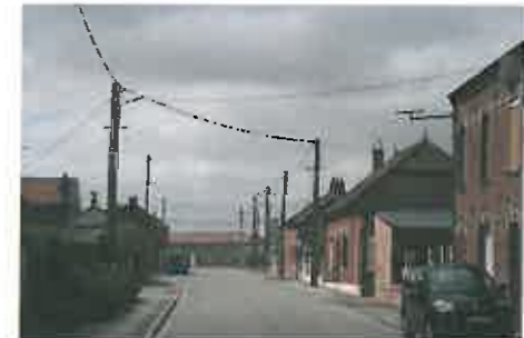
Marcelcave, rue de la Gare avant travaux
